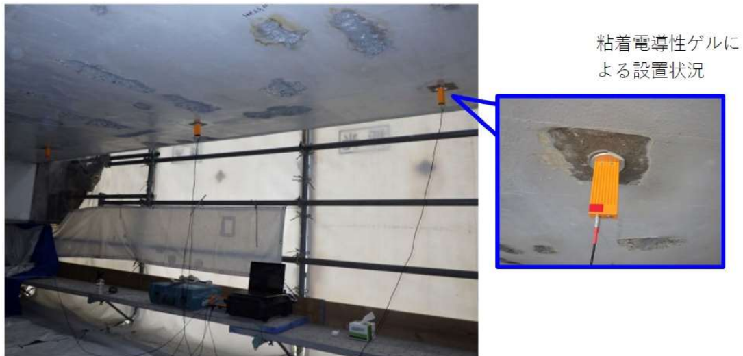
写真-2 鉄道高架橋補修工事での測定状況
