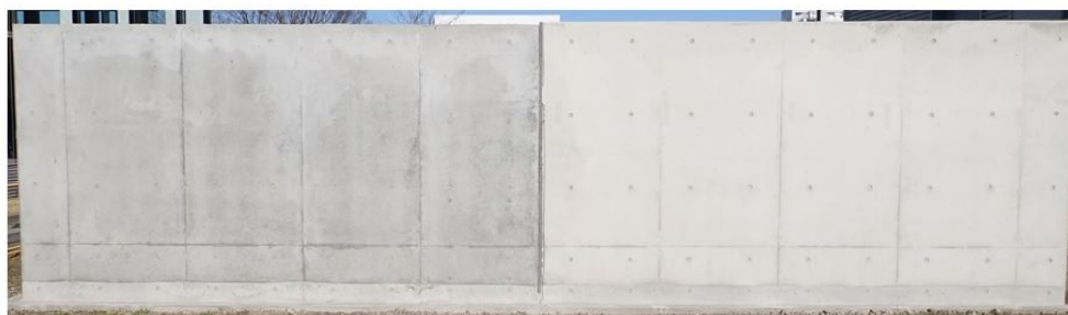
写真2 構築した壁部材の出来栄 ( 左側：従来のコンクリート 右側：ハイプロダクリート )
