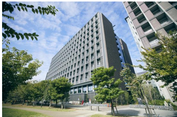
葛飾キャンパス新棟（共創棟）外観
