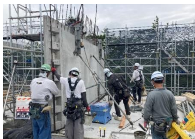
〔PC 板の揚重・取り付けの様子〕
