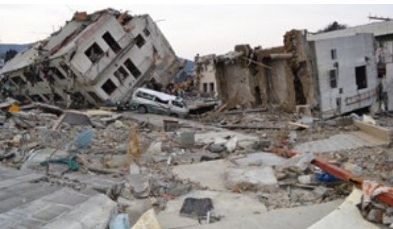
▲2011年東日本大震災時の津波による建物被害
