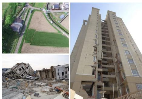
永野研究室では、大地震後に建物の被害調査を行うとともに、地震・建物の記録を分析し、シミュレーション解析を行っています。そうして揺れや被害の要因を探ることで見えてくるものも多いといいます。
