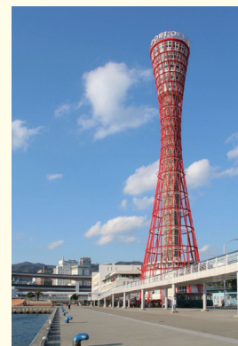
神戸ポートタワー
