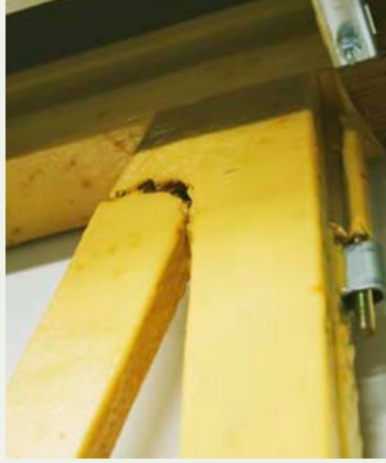
樹脂などを塗ることでもある程度の耐震補強が可能となる。
