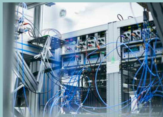
冷却装置を制御する装置
