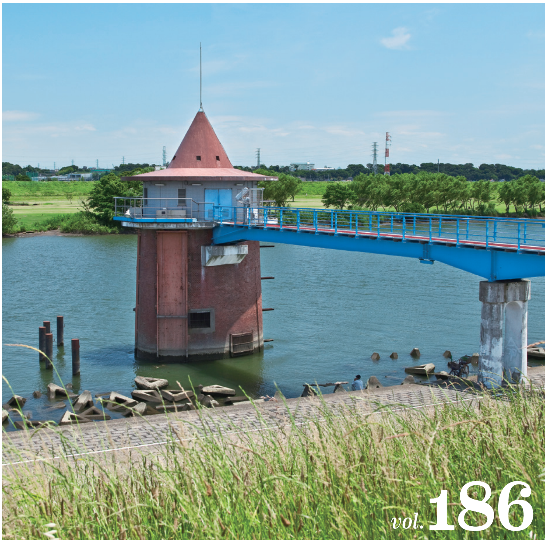
江戸川に立つ金町浄水場の取水塔
