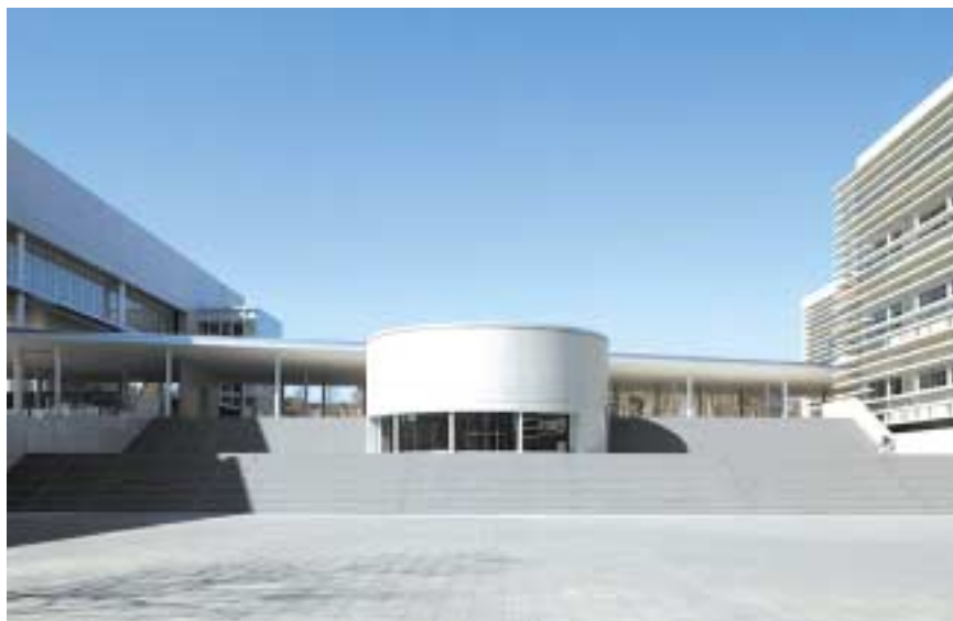
メイン2棟の間の学生ホールと広場
