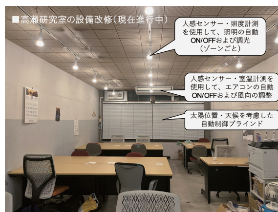
【図7】 高瀬研究室で導入している照明・エアコン・ブラインドの自動制御実装状況
