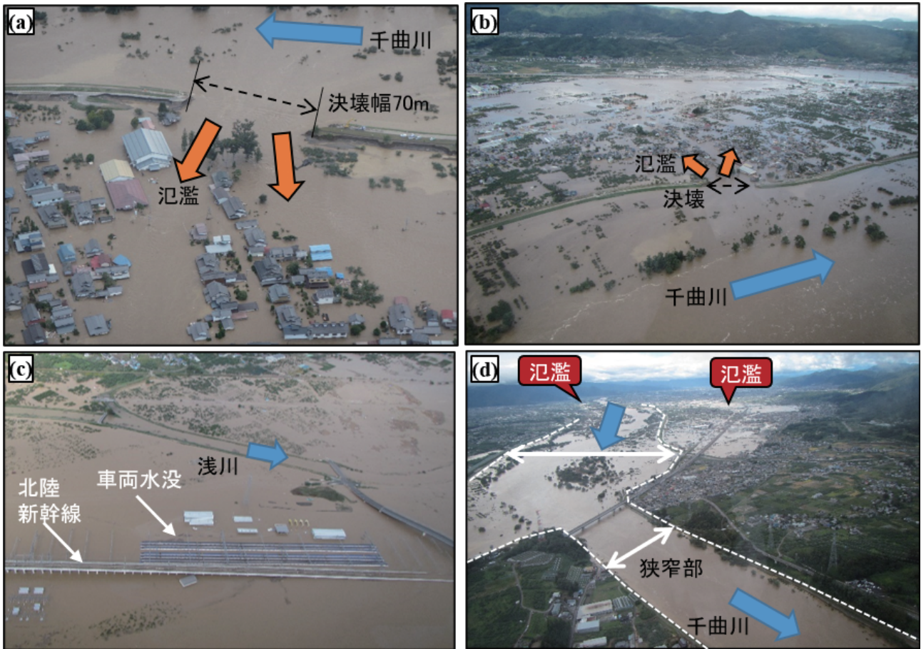
【図3】千曲川流域における洪水氾濫の様子（ヘリより 2019/10/13 10 時頃に撮影）
