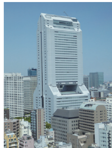
【図9】ビル風低減のため中空部分を設けたビル 3)
