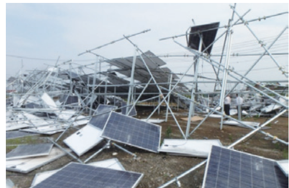
【図6】太陽光発電設備の被害例 1)
