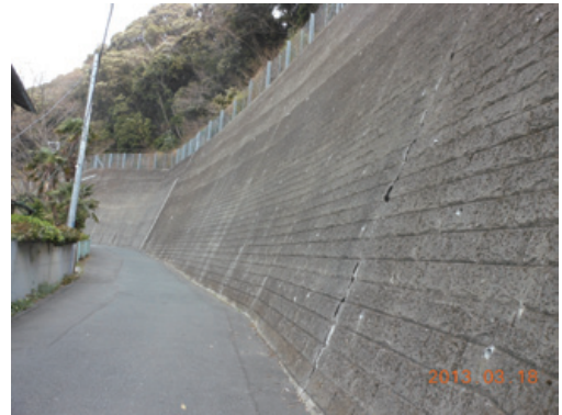
【図2】斜面の安定性を高める擁壁の例
