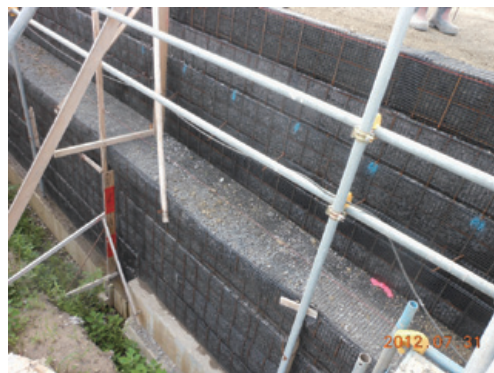
【図7】ジオグリッドを用いて地盤を補強しているところ
