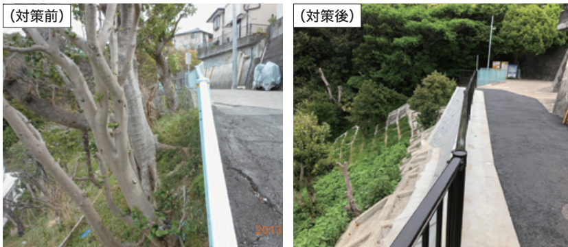
【図3】法面補強による危険な斜面への対策
