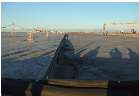
【図6】固化処理をした粘土を施工している様子
