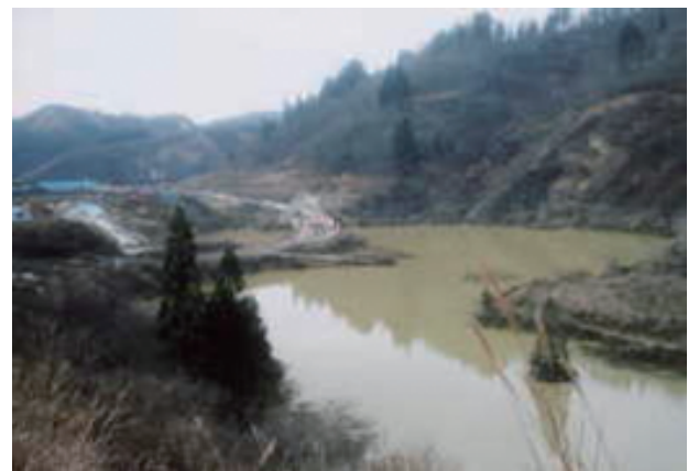
【図8】崩壊土砂の自然ダム形成による河道閉塞
