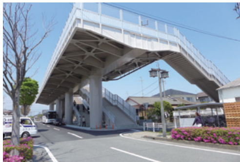
【図2】津波避難タワー 襲来する津波から、一時500人の身を守るためのタワー
