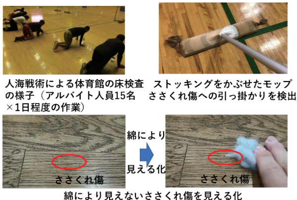
【図3】人海戦術による体育館床検査と綿によるささくれ傷の見える化
