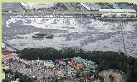
写真2 東日本大震災（2011年）での液状化で噴出した泥土で覆われた千葉県のテーマパークの駐車場（防災ニッポン HP）
