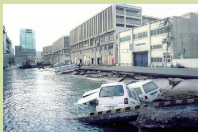
写真1 阪神淡路大震災（1995年）での液状化による港湾岸壁の損壊（神戸新聞）
